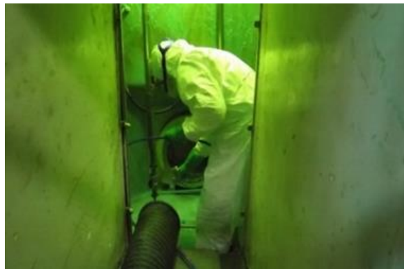
Figura 2.3: Pulverizare decontaminant [1]
