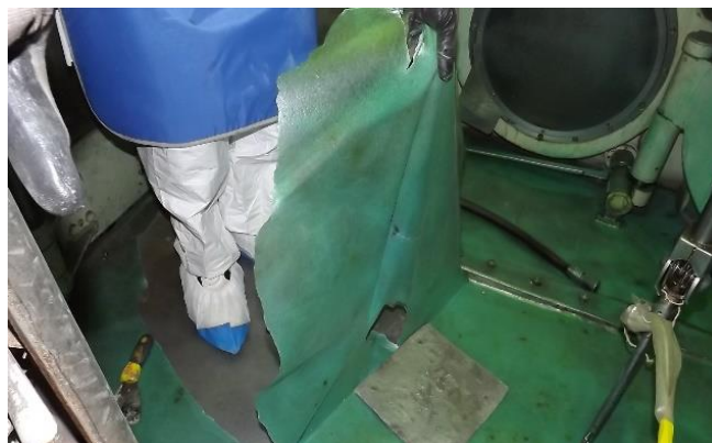
Figura 2.5: Îndepărtare decontaminant de pe podea [1]
